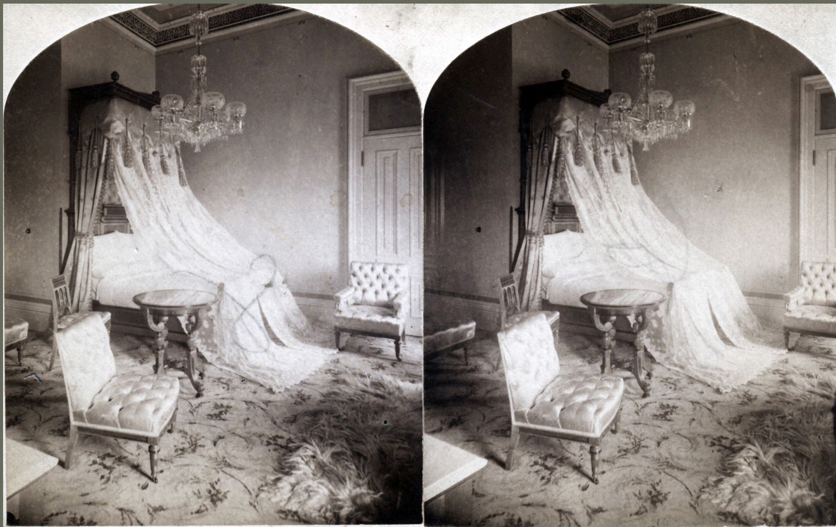
Une chambre du Windsor, vers 1880 (photo : William Notman)
