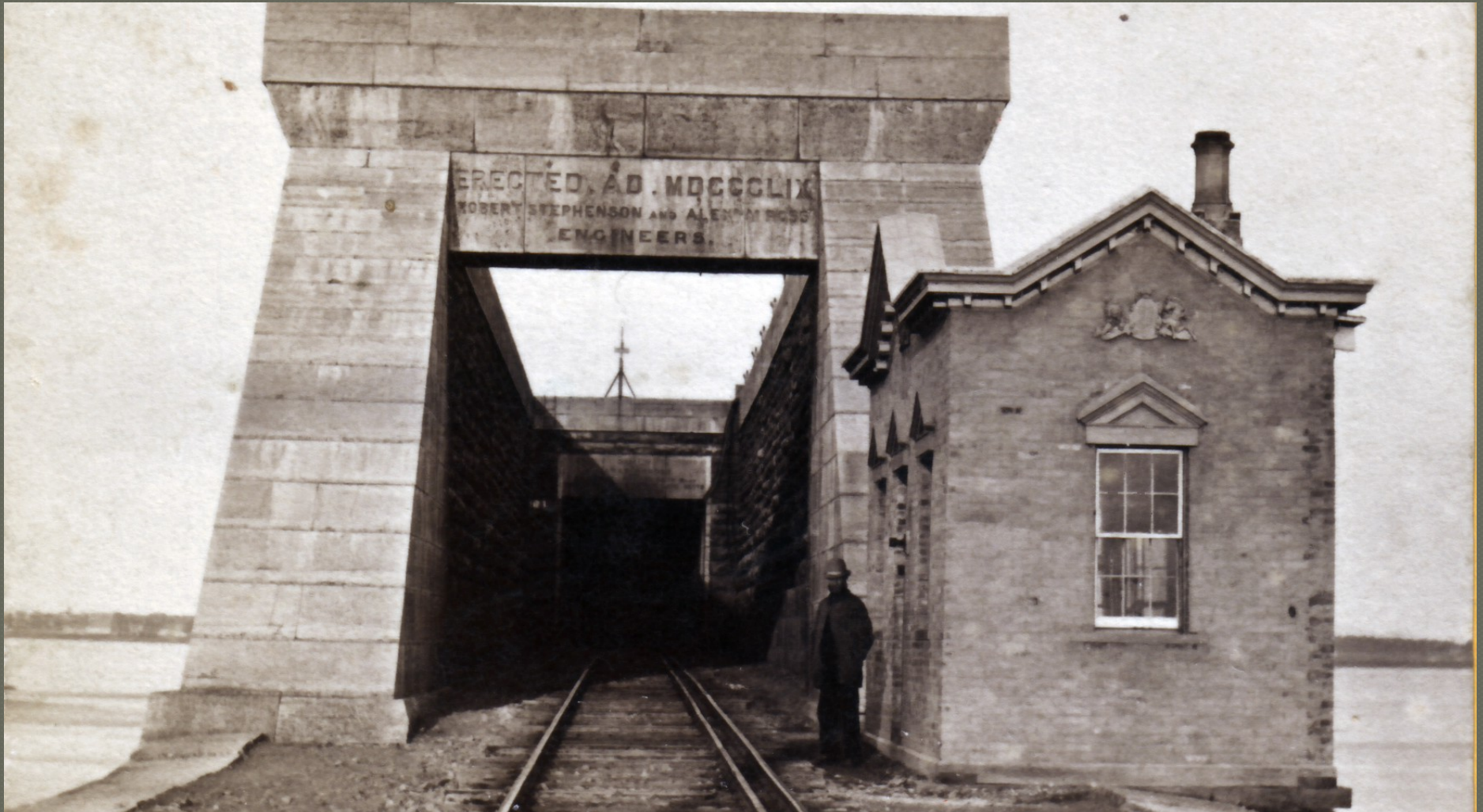
Le guérite à l'entrée nord du pont Victoria (photo : Kilburn Brothers)
